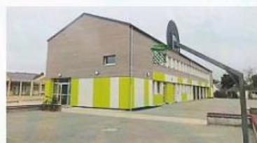
Le bardage d'un bâtiment de l'école Jules-Ferry a fait peau neuve cet été.
